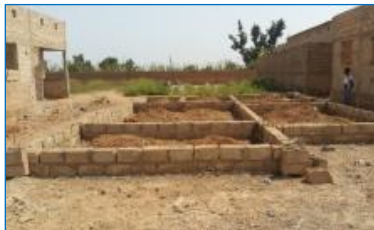
2020 : les fondations se profilent
