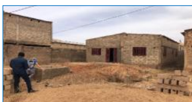
2022 : La maison est debout, Marie et Valérie (VSQP) visitent le chantier
